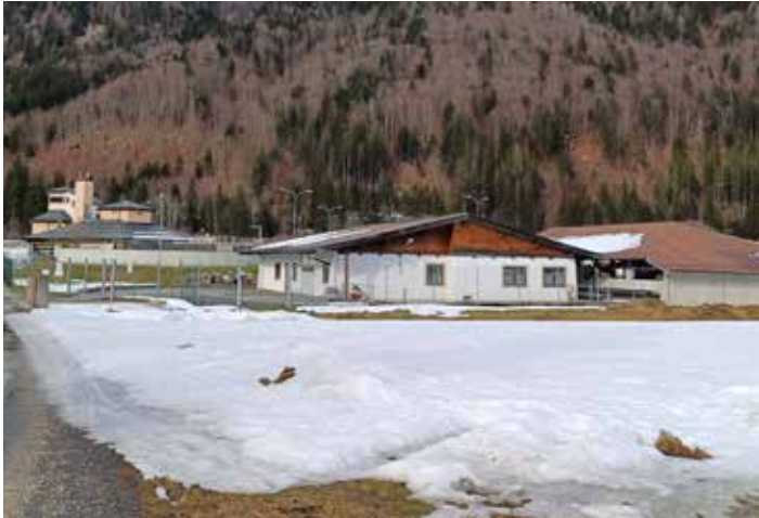
In der Verbandskläranlage werden die Abwässer der Gemeinden Waidring und St. Ulrich gereinigt.
