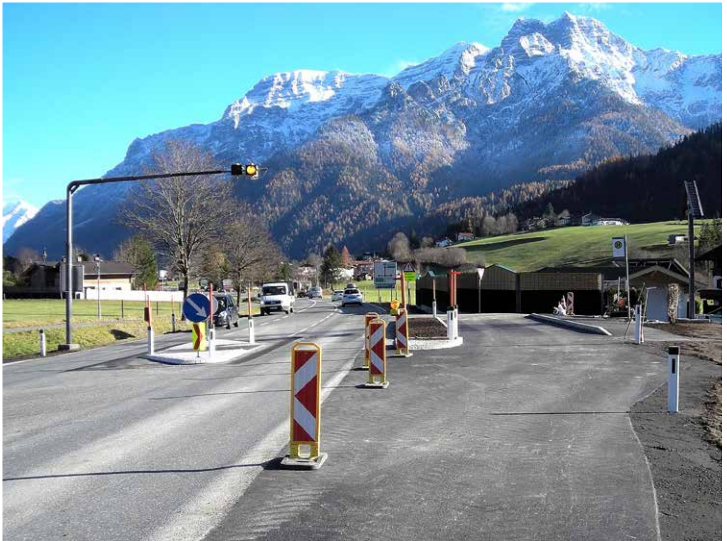
Die umgebaute Kreuzung bedeutet ein Mehr an Sicherheit für die Fußgänger.
