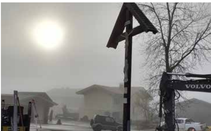
Umsituierung des Auergass-Kreuzes in Folge Straßensanierung
