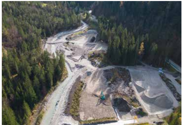
Der Bau des Retentionsbeckens erfordert große Materialbewegungen Foto: klubarbeit.net
