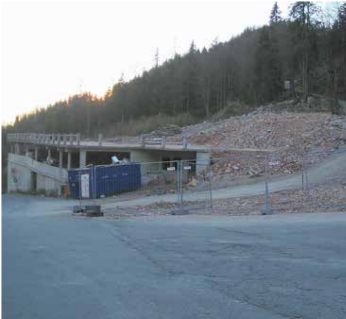
Vom Schandfleck Steinplatte ist nur mehr die Tiefgarage sichtbar
